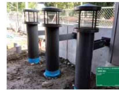
アースチューブ施工写真
